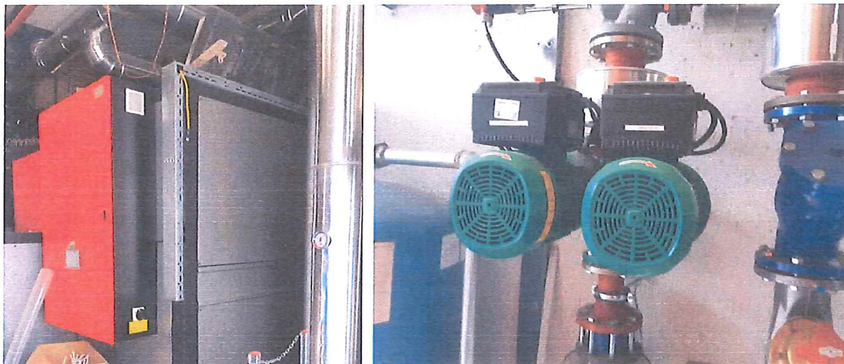
Slika 3: Posnetek dela razdelilnika in kotla na biomaso
